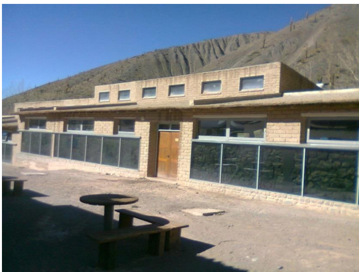
Fig. 2. Muros colectores-acumuladores. Colegio Secundario Albergue de Montaña “El Alfarcito”, Quebrada del Toro, Salta, Argentina.
