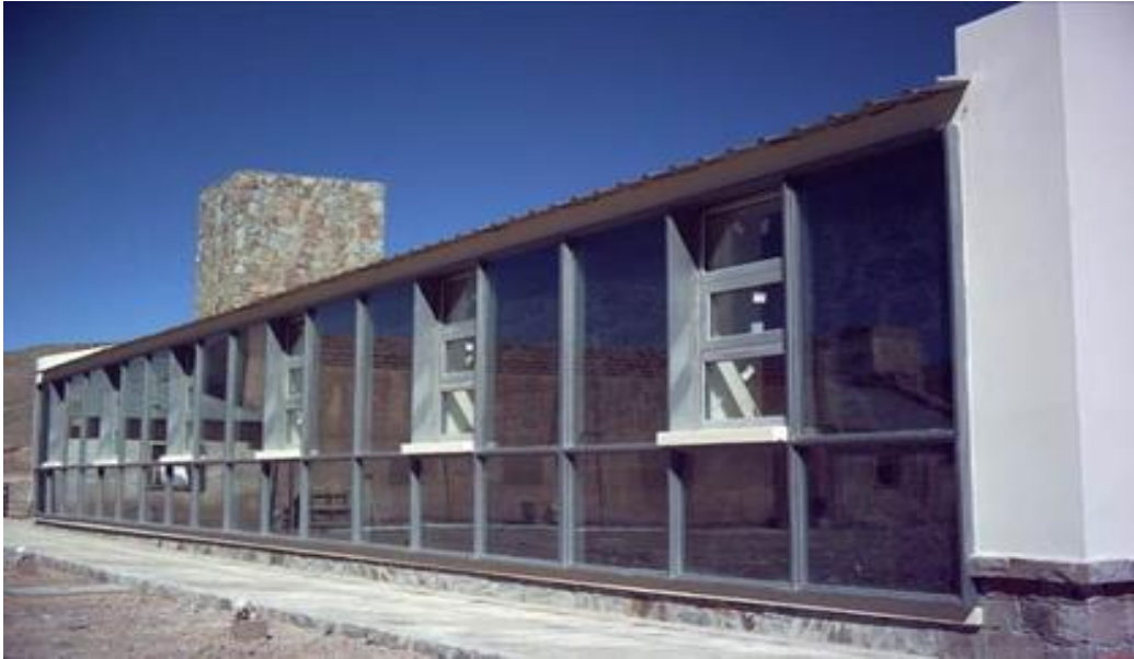
Fig. 8. Hospital Bioclimático de Susques (Jujuy). Vista de los muros colectores-acumuladores
