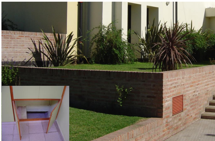
Fig. 4. Conductos enterrados. Vista de la toma exterior y boca de salida del aire. Diseño arquitectónico: Dra. Arq. Celina Filippín.
