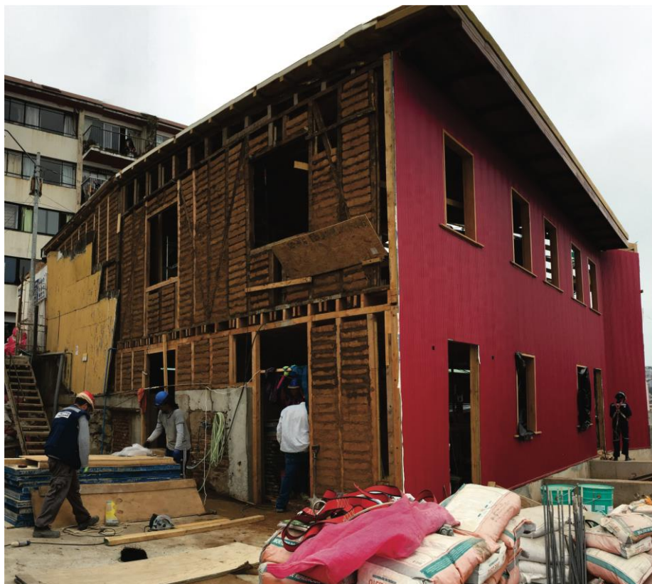
Figura 1. Adobillos del ascensor Concepción, obra de restauración del ascensor Concepción, Flesan Restauraciones, Valparaíso, Chile, 2017
