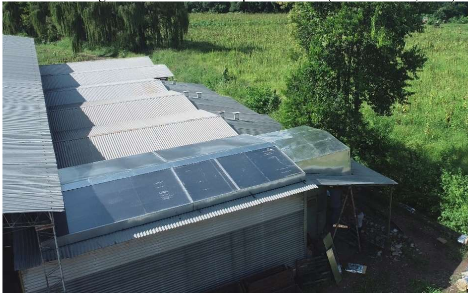
Figura 4: Fotografía aérea del sistema propuesto ya instalado en los techos de la estufa
