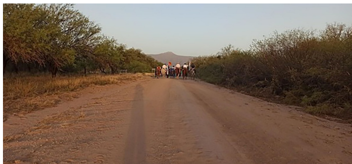
Imagen 1. RP No. 28, desde Chancaní hacia el Camino de Los Túneles
