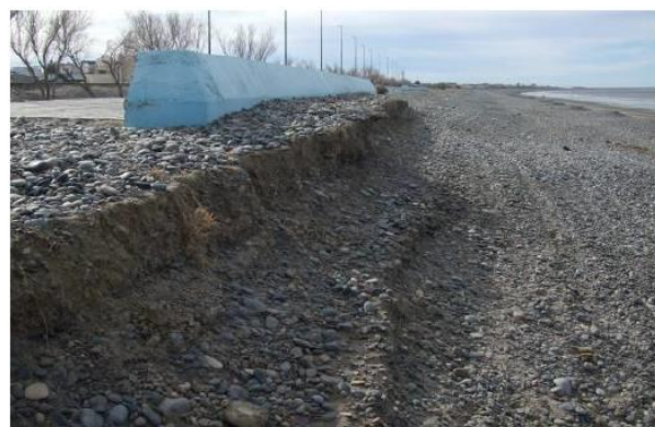
Fig. 9. Erosión al norte del espigón corto en agosto del 2010.
