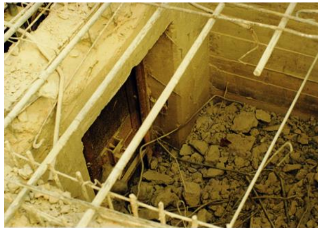
Interior de la caja fuerte, se ve la puerta de seguridad en su sitio.
