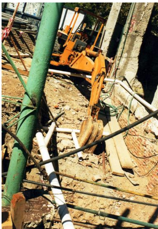
Inicio de la excavación del techo del búnker en 1999.
