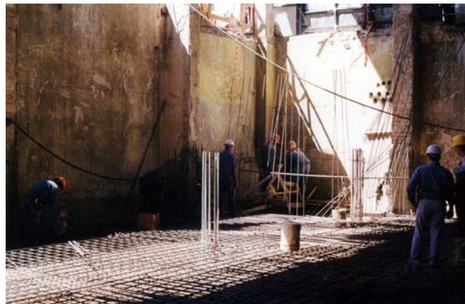
Interior del búnker una vez liberado de muros interiores e iniciada la obra nueva.
