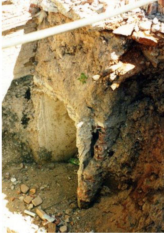
El túnel principal durante su destrucción.
