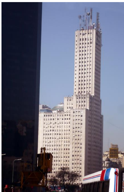
Edificio Alas, el más alto de la ciudad durante medio siglo. Por detrás estaba el Alea nunca completado.
