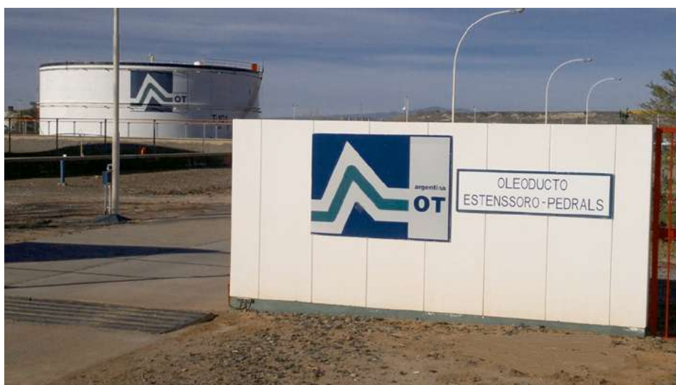
Figura nº 20. Oleoducto Trasandino Estenssoro-Pedrals.
