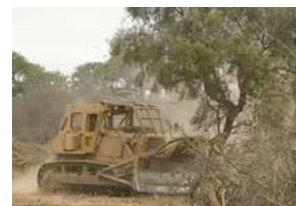
Figura n° 24. Desmontes en la provincia de Salta.
