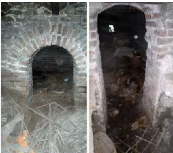
Arcos de paso entre habitaciones superiores de diversa altura interna.
