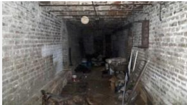
Entrada a las galerías bajo el edificio.
