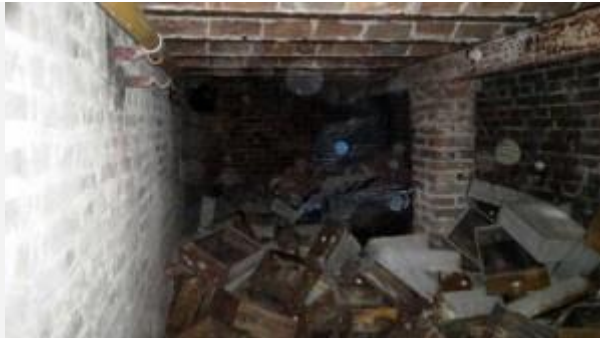
Techo de bovedilla, en el interior docenas de cajones y muebles descartados.
