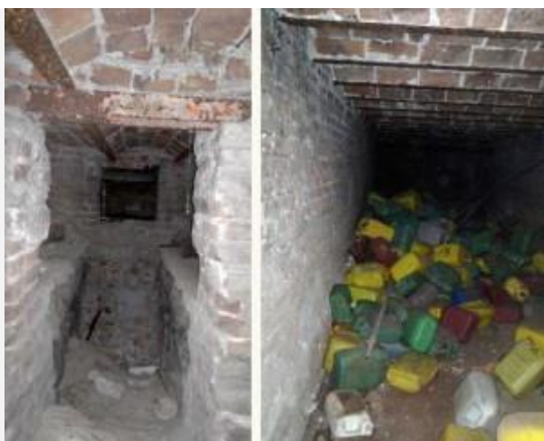
Izquierda: zanja moderna y perforación; derecha: docenas de bidones descartados.
