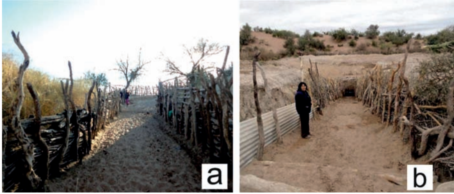
Figura 8. Materiales empleados en la contención vertical del suelo excavado: a- aprovechamiento de vegetación autóctona; b- uso de chapa acanalada.
