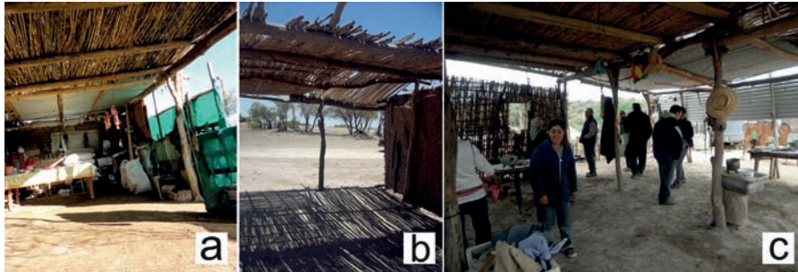
Figura 5. El espacio semicerrado de la casa habitación: a) elementos de la vida diaria en el espacio semicerrado; b) uso de caña para la cubierta y c) combinación de chapa acanalada y caña.
