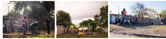
Figura 4. Construcción del Domo en barrio Campo de la Ribera, Córdoba, Argentina Fuente: Agrupación Mazamorra, Córdoba.
