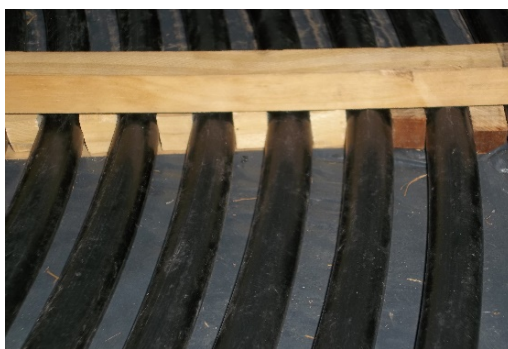
Figura 3: Foto de ubicación de la manguera absorbadora mostrando la separación entre espiras.
