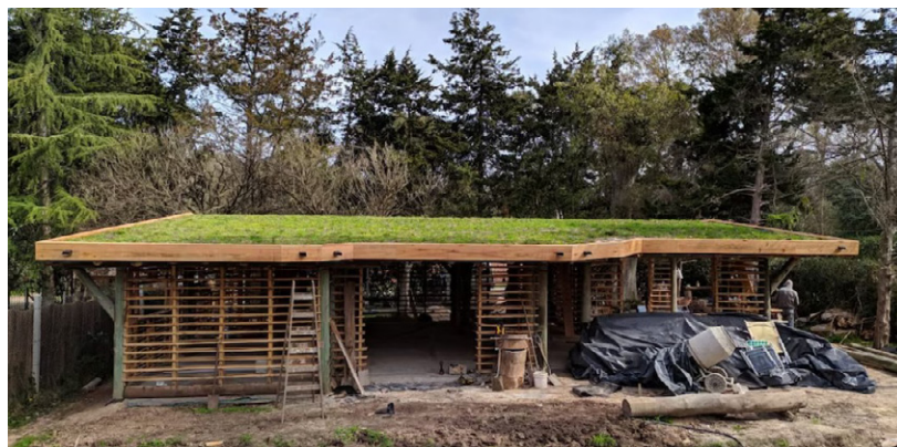
Figura 5. Bioconstrucción con caña, pasto, barro y techo verde
