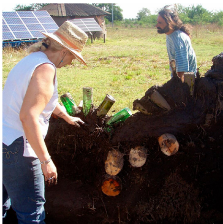
Figura 9. Bioconstrucción en barro y materiales reciclables
