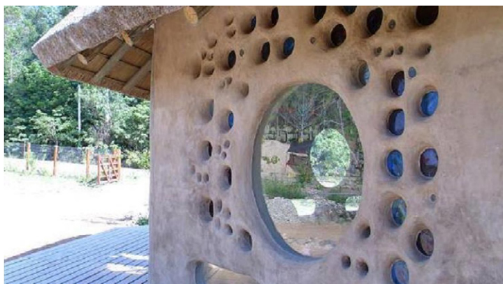
Figura 10. Bioconstrucción en barro y materiales reciclables
