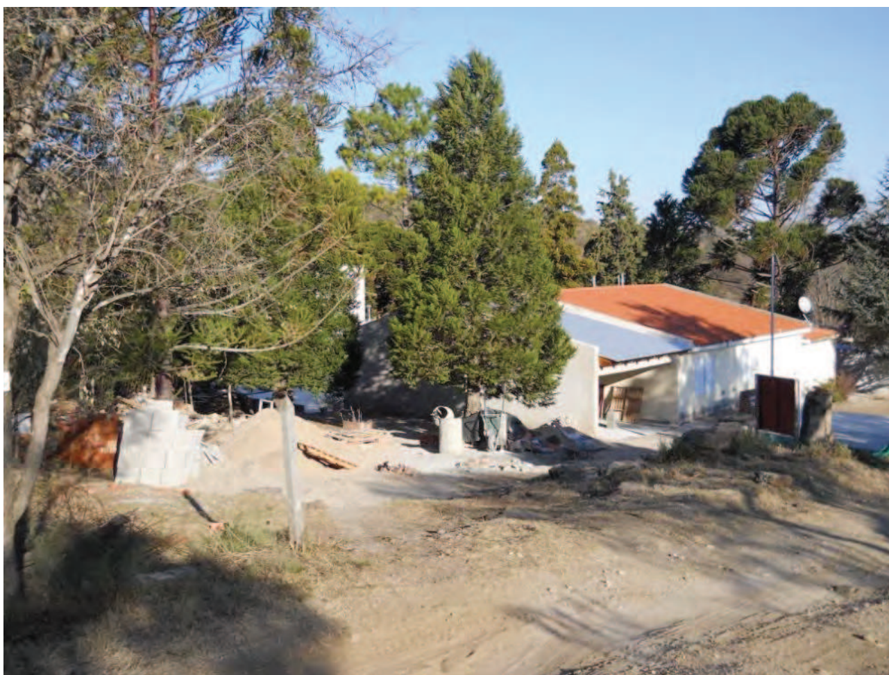
Figura 3: La Escuela Hernández, en obras de construcción. Julio de 2011
