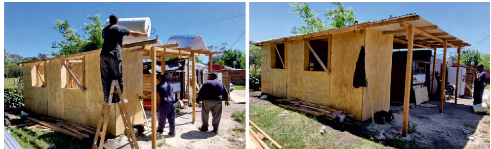
Figura 14. Ejecución de cubierta Fuente: Elaboración propia
