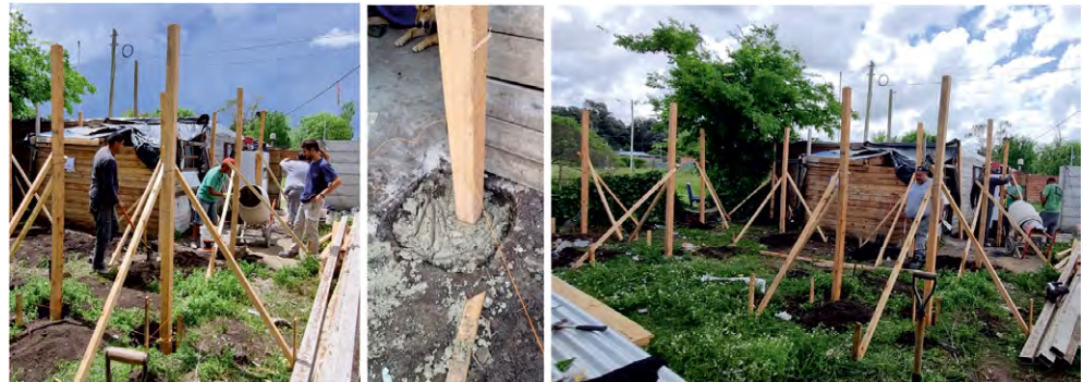
Figura 11. Replanteo, nivelación y aplomado de columnas.
