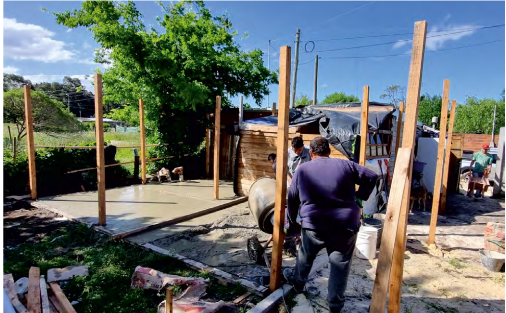
Figura 12. Llenado de contrapiso con AFR.
