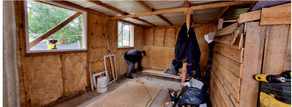
Figura 15. Colocación de aislación termoacústica y panelizado interior.
