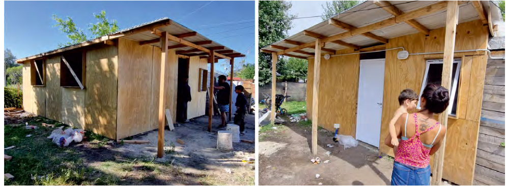
Figura 16. Colocación de aberturas.
