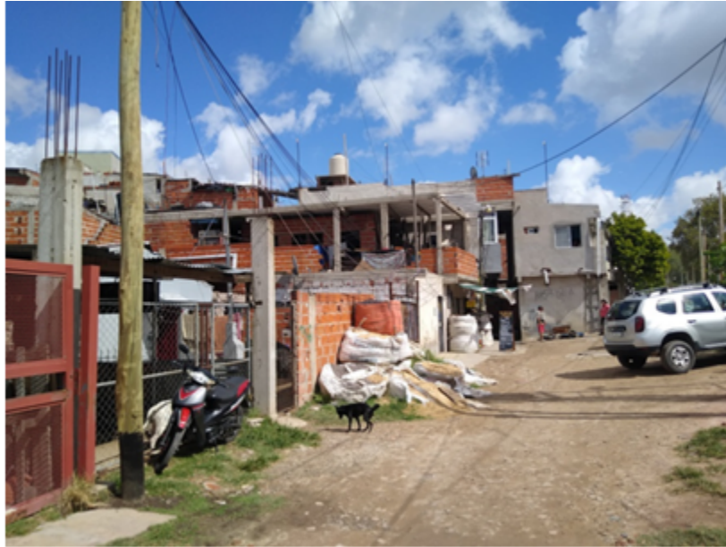
Figura 1 Imágenes del barrio en estado de obra permanente
