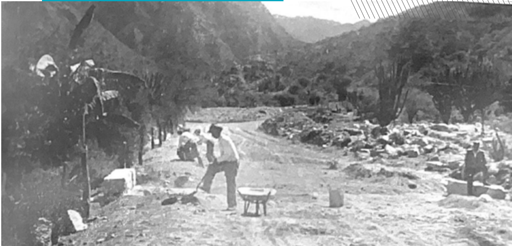
Construcción de calzada en la entrada de La Rioja. Memoria DNV, 1938.
