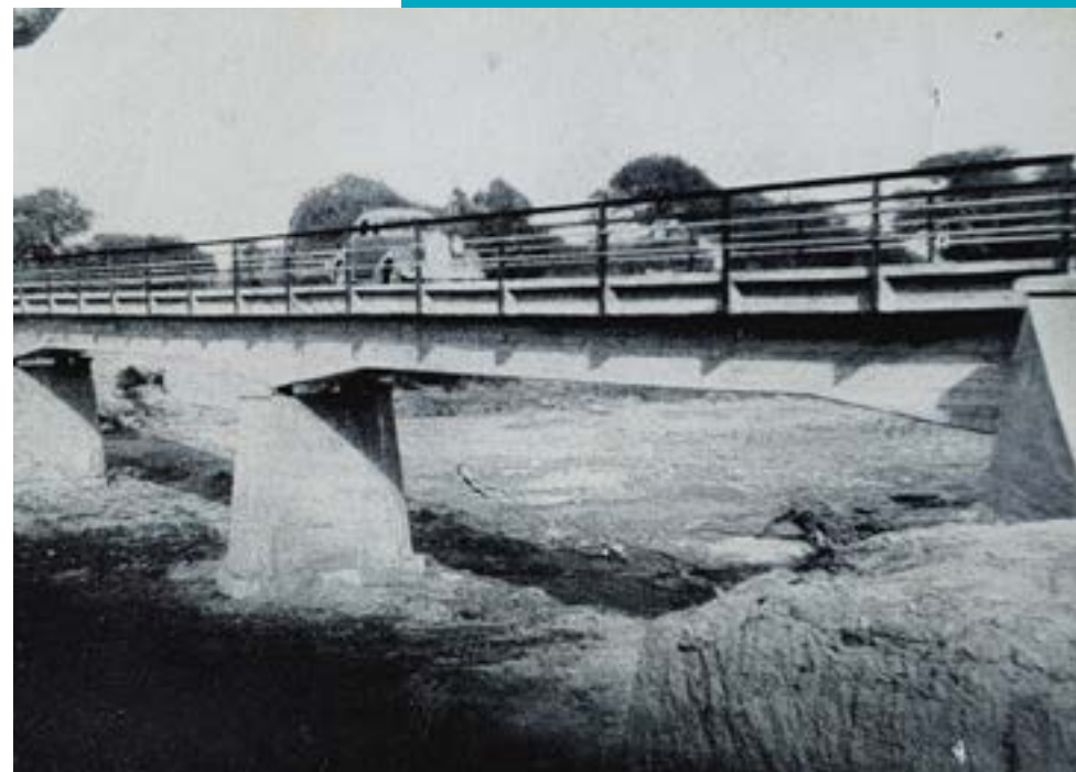
Puente sobre el río Mojotoro, Salta. Memoria DNV, 1936.
