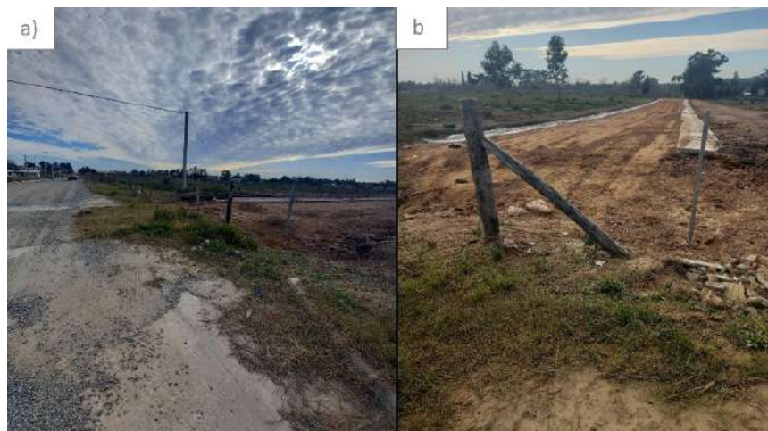
Figura 8. Vista de las obras en dos calles de la ciudad
