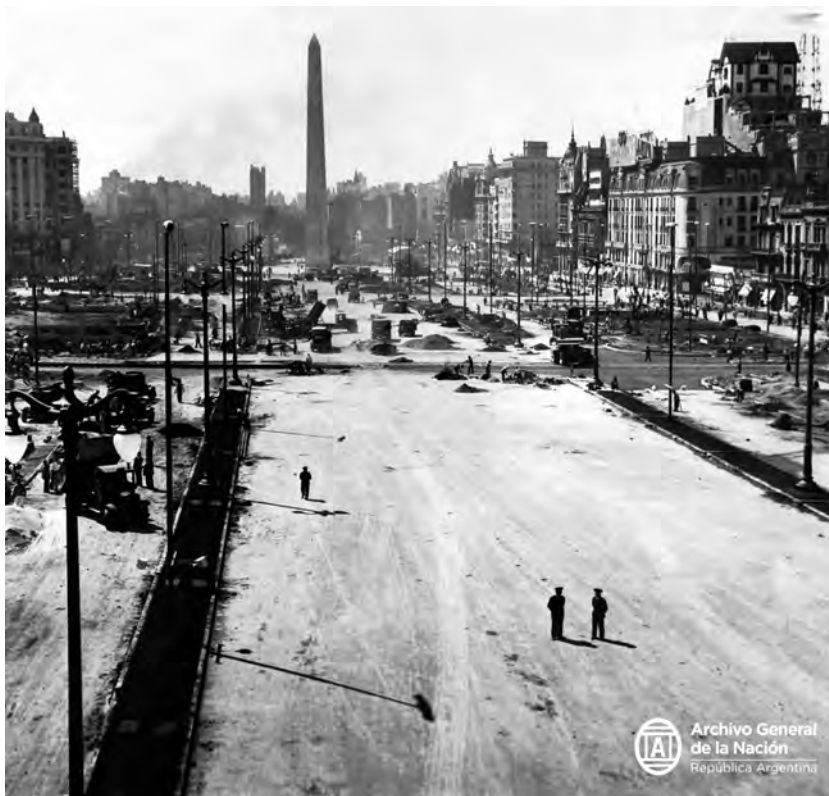
Obras en la avenida 9 de Julio. Buenos Aires, octubre de 1937. Archivo General de la Nación. Documento fotográfico. Inventario 4379.
