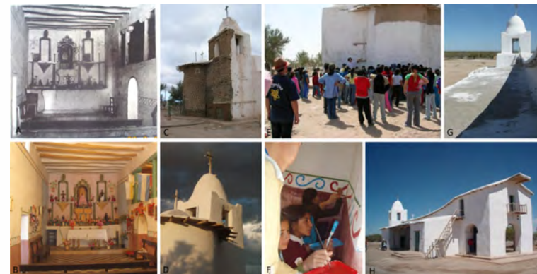
Figura 1. imágenes de la capilla de Nuestra Señora del Rosario: Interior de la capilla (A); Recuperación de pinturas decorativas realizada de manera voluntaria por la comunidad (B); La torre con su cúpula de hiladas avanzadas restaurada (C); La torre con su cúpula de hiladas avanzadas restaurada (D); Talleres con la comunidad y la escuela (E); Trabajo voluntario de la comunidad, alumnos de la escuela Elpidio González (F); Vista de las cubiertas y torre (G); inauguración de la restauración (H).
