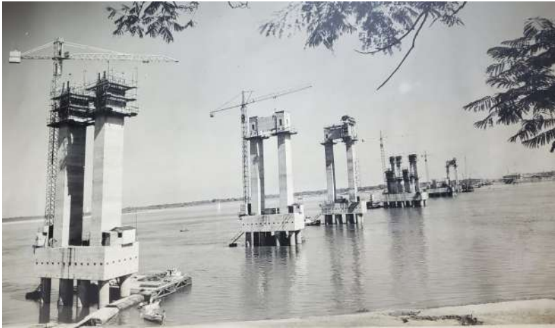
Fotografía 1. Construcción puente Gral. Belgrano
