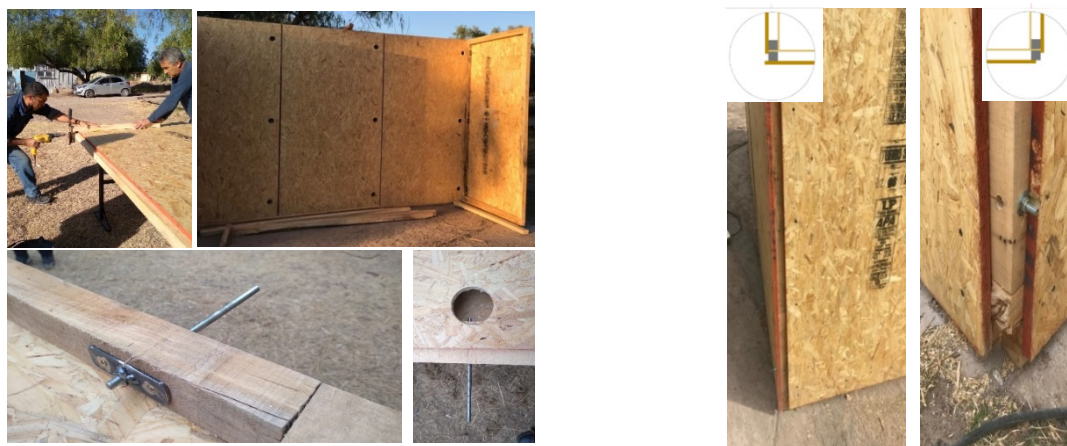
Figura 7. Armado de paneles
