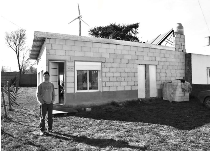
Figura n.º 1. Residencia particular con equipamiento en energías renovables en Pigüé, Buenos Aires
