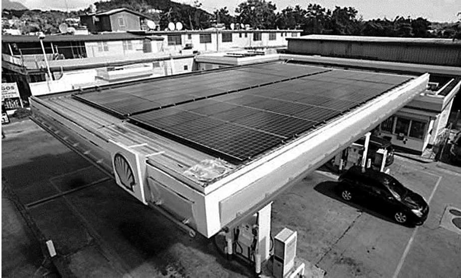
Figura n.º 3. Terraza con paneles solares en estación de servicio Shell, Ciudad Autónoma de Buenos Aires
