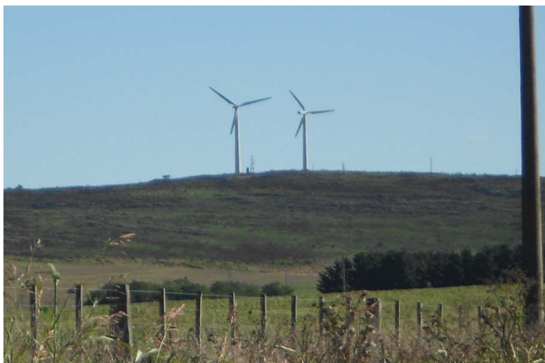
Foto N° 2. Parque Eólico Cooperativa Rural Eléctrica Tandil-Azul Limitada (CRETAL). Tomada en Febrero 2014.
