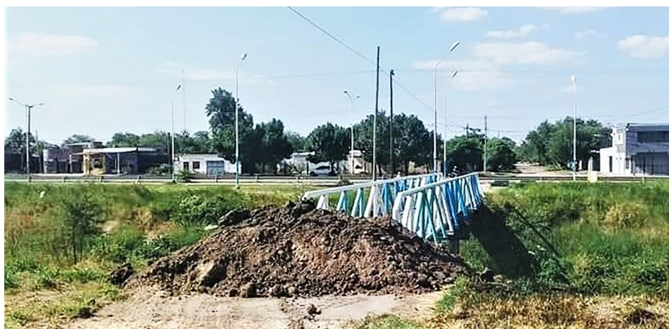
Imagen 4. Cierre de puente en Av. Nicaragua y José Ma. Paz - Zona Sur de Resistencia
