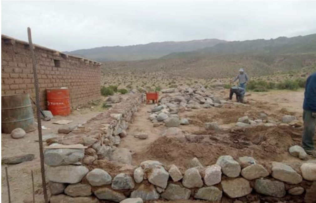
Figura 1. Minga para la construcción de la casa comunitaria en la comunidad indígena La Hoyada (2022).
