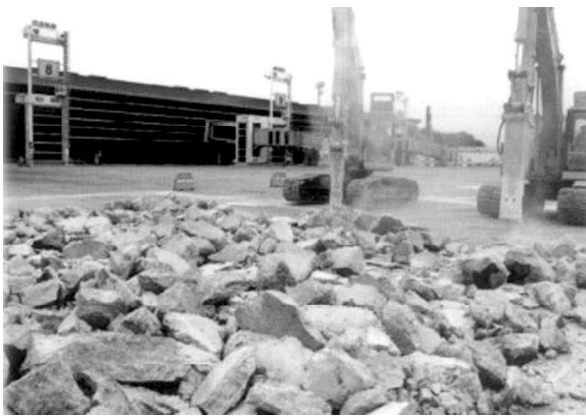
Figura 4. Generación de AR procedente de la demolición de pista de aterrizaje en Aeroparque Jorge Newbery. (Adaptado de [36]).
