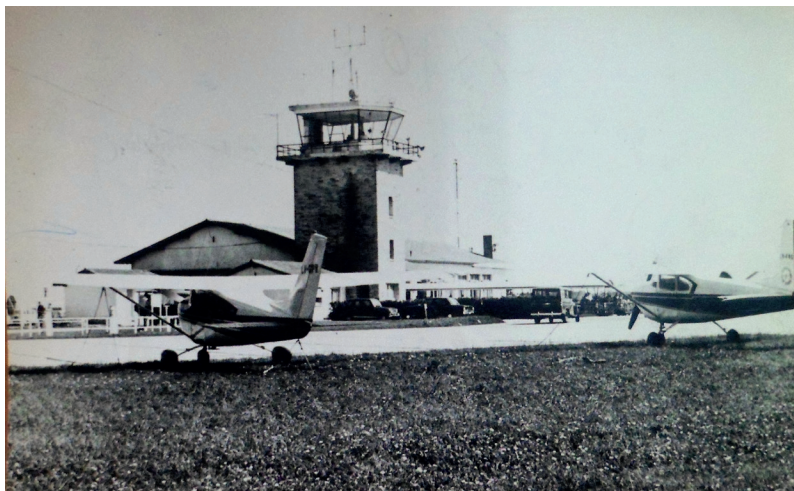
”Vista del aeropuerto de Mar del Plata” Fototeca Diario La Capital , noviembre de 1970
