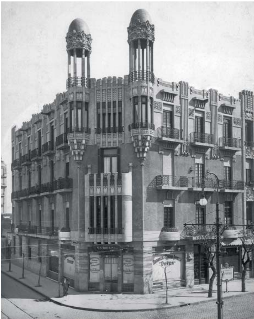
Edificio de renta. Arq. Julián García Núñez. Año: 1911. Av. Independencia 2014, esquina Sarandí, Buenos Aires. Comitente: Sociedad Española de Beneficencia. Autor fotográfico de archivo: José Pleuriot.
