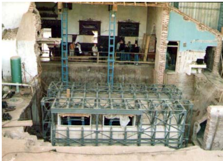
Sistema utilizado para sacar el mural del sótano después de desbastar los muros y reemplazarlos por una estructura liviana de acero en 1989 (foto archivo del proyecto).
