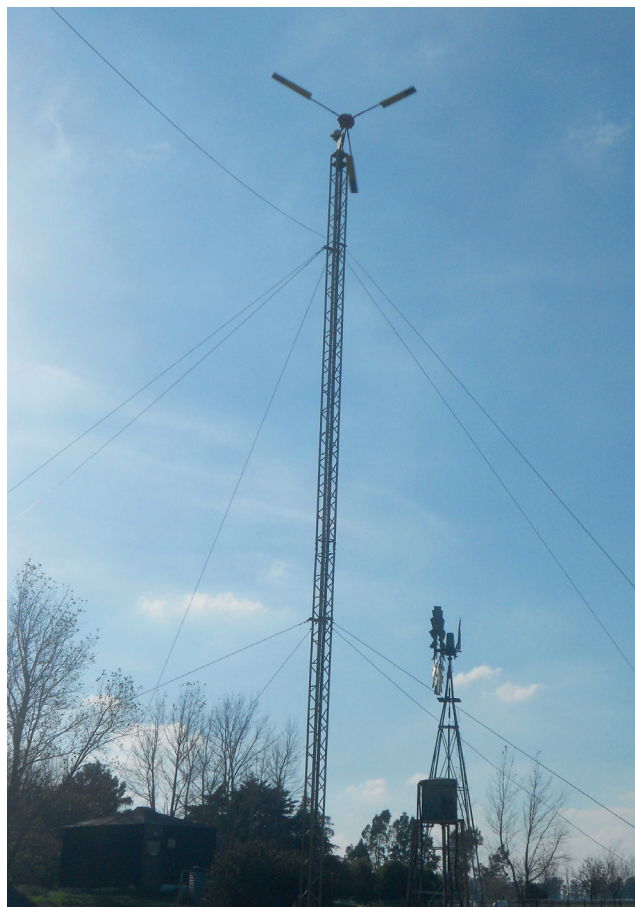
FIGURA 1. Molino eólico y aerogenerador de baja potencia en Escuela Agrotécnica Tres Arroyos (provincia de Buenos Aires)
