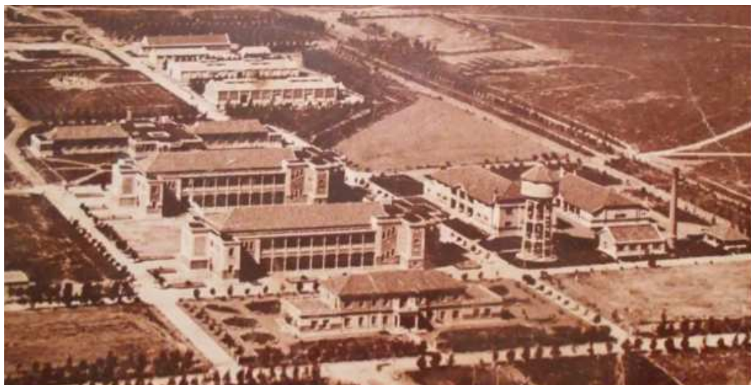
Fig. XI. Guarnición Militar en Bahía Blanca, en construcción, 1917.
