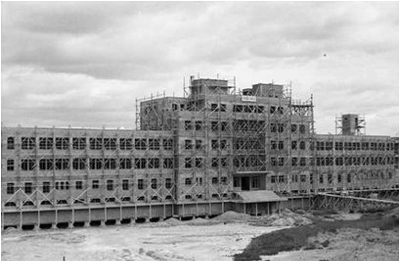
Imagen Nº 1. Construcción del Hospital Regional de Comodoro Rivadavia, en la parte superior y central se ubica el letrero con la leyenda PERON CUMPLE. José González. c.1951.
