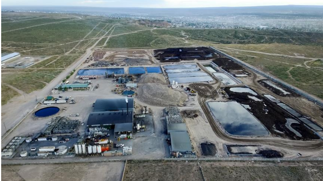
Imagen 1: Vista de la planta de tratamiento de COMARSA en el Parque Industrial de la ciudad de Neuquén. Fecha: 12/10/2016. Fotografía: Fabián Ceballos.
