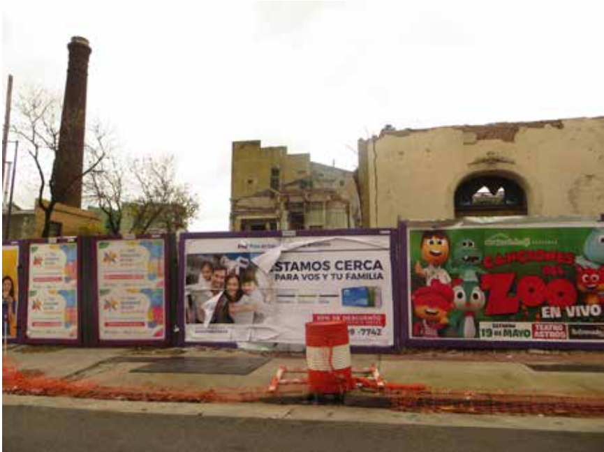
Figura 8. Construcción en ruinas.
