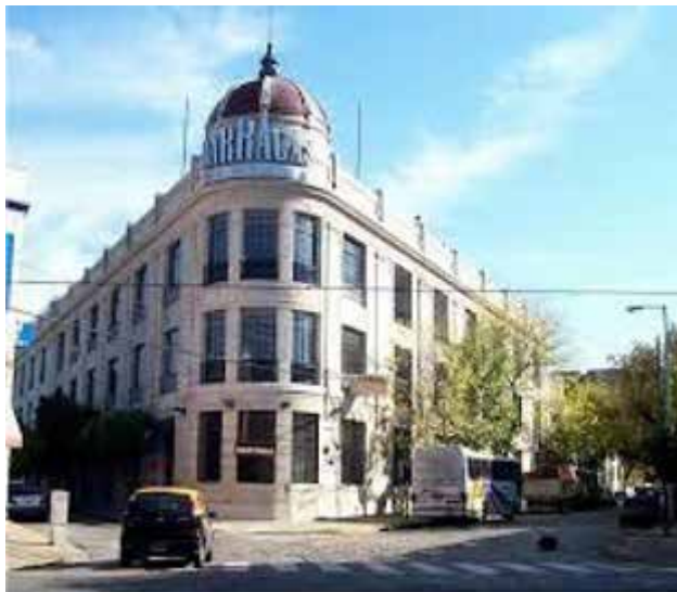
Figura 6. Fábrica ex Piccaluga refuncionalizada y renombrada como Barracas Central.
