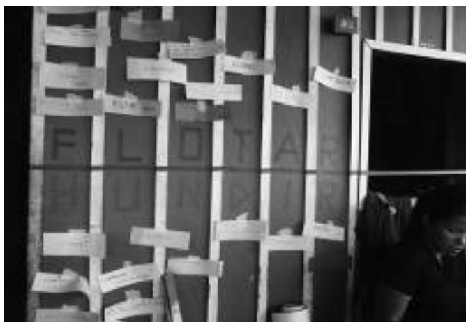
Figura 4_ Docentes y alumnos del Taller Matéricos Periféricos construyendo en un barrio industrial de Santa Fe (Argentina). Fuente: http://www.matericosweb.com/
