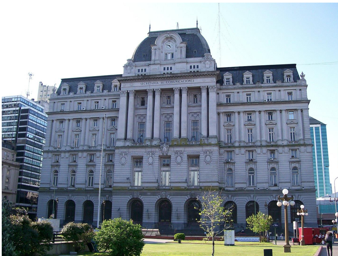
Figura 3. Palacio de Correos y Telecomunicaciones. Ciudad de Buenos Aires, Argentina.
