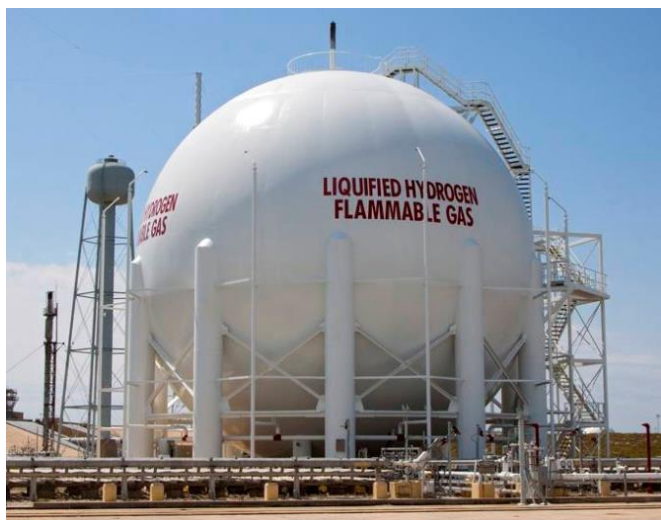
Fig. 2. Tanque esférico para almacenar hidrógeno líquido
