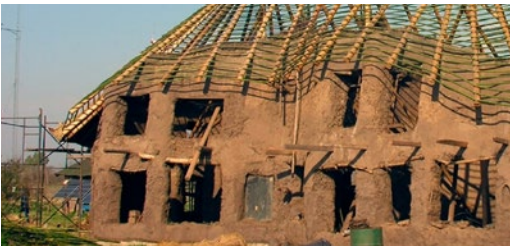
Construcción en Ecovilla Gaia. Fuente: Asociación Gaia.
