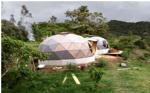
Formas bioconstructivas. Ama Gi. Fuente: Ecomunidadamagi.
