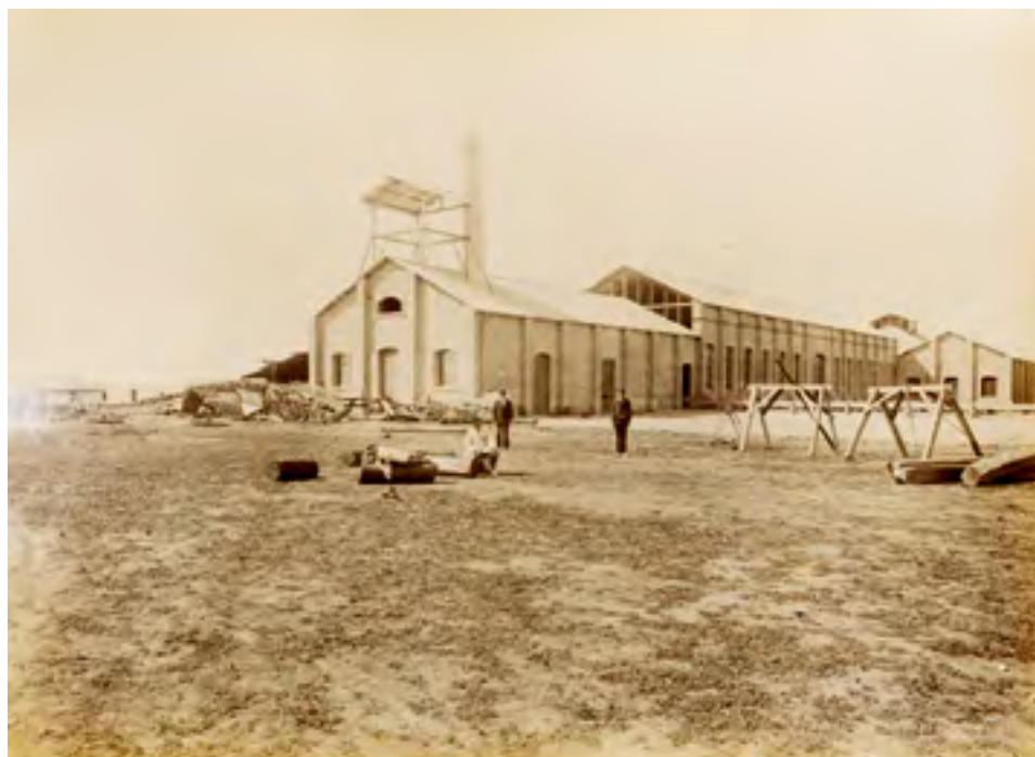
Figura nº 4. Ingenio azucarero de Tacuarendí, a tres leguas al norte de Ocampo: Establecimiento ricamente montado, que puede fabricar 700 arrobos de azúcar en 24 horas. En 1886 produjo 53,000 arrobos de azúcar y 350 tercerolas de aguardiente de 40 grados/vistas tomadas por el fotógrafo F. Corte, 1887. Fuente: Biblioteca Nacional Mariano Moreno.
