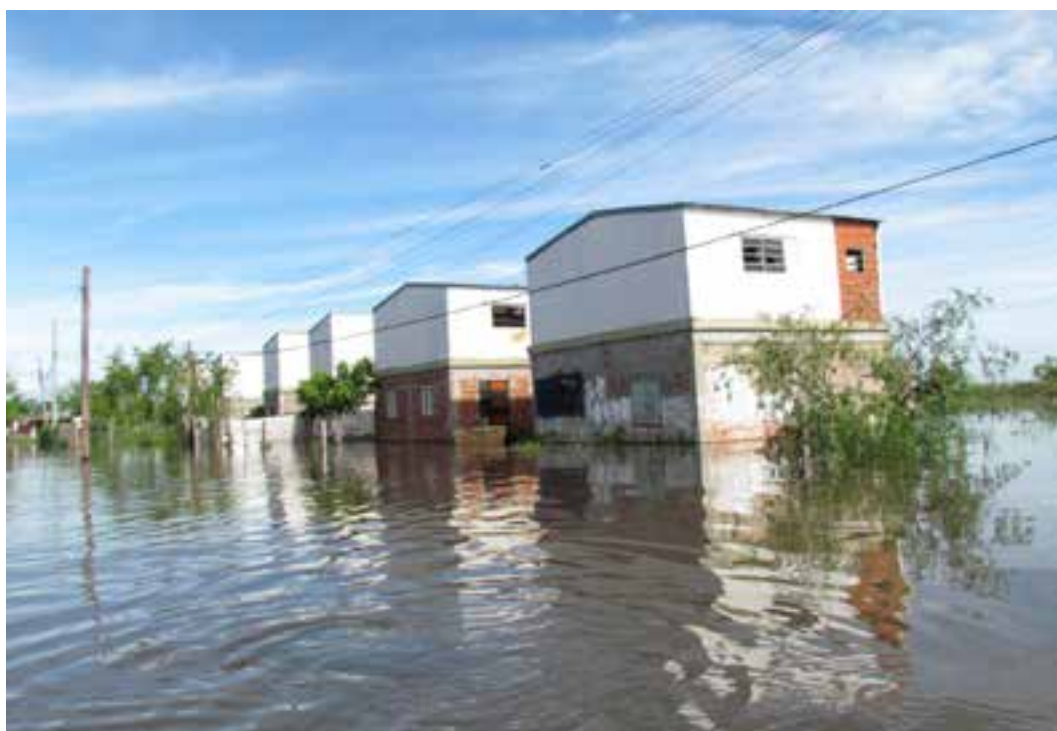
Imagen 5: Casas con segundo piso. Fuente: Proyecto Revuelta http://santafeciudadinundada.blogspot.com/2015/
