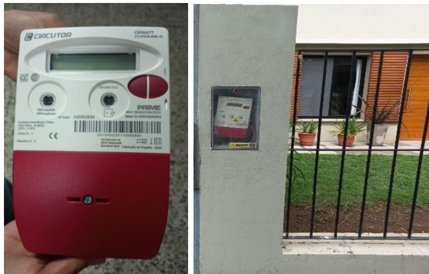
Fig. N°3: Medidor inteligente, instalado en vivienda de Trenque Lauquen
