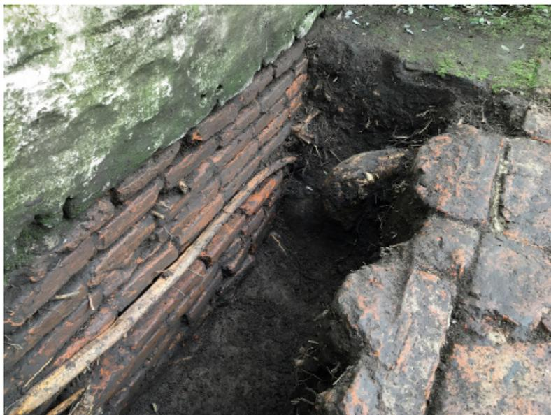
*Figura 10 - Perfil del sondeo 3, a la izquierda se observa el cimiento del muro perimetral.*
