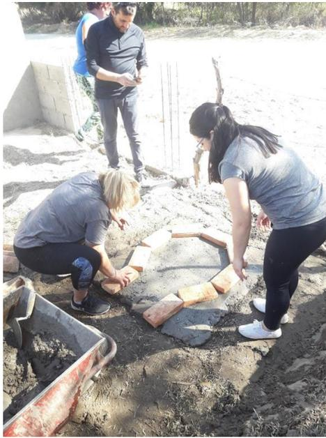
Figura 6. Armado de la base del horno
