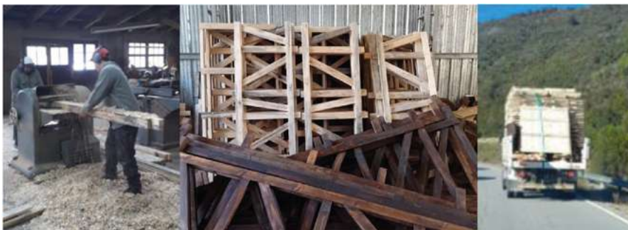
Fig. 8, 9 y 10: Trabajo de producción desarrollado en Bariloche y traslado a Lago Puelo de los componentes constructivos. Fuente: Archivo fotográfico del programa Co-construcción del Conocimiento.
