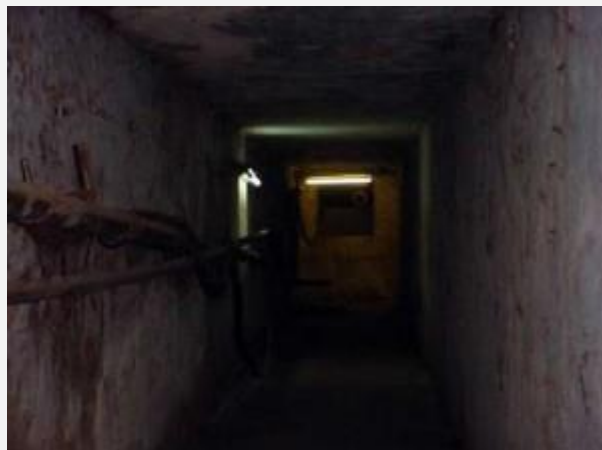
Fotografía que muestra las dimensiones de estas galerías en su sección principal (foto archivo CAU).
