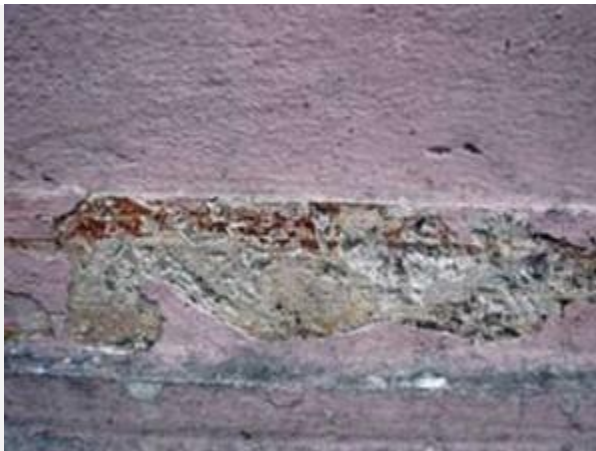
Detalle del color original de los muros y líneas horizontales rojas que lo contorneaban
