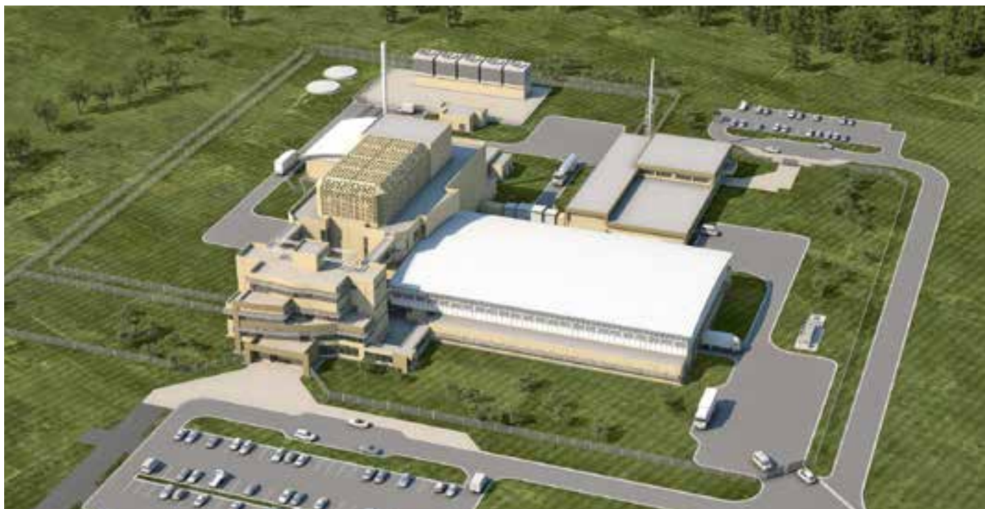
Imagen digital del complejo científico-tecnológico RA-10 en el Centro Atómico Ezeiza, que incluye las instalaciones de instrumentación neutrónica del Laboratorio Argentino de Haces de Neutrones (LAHN). Imagen CNEA
