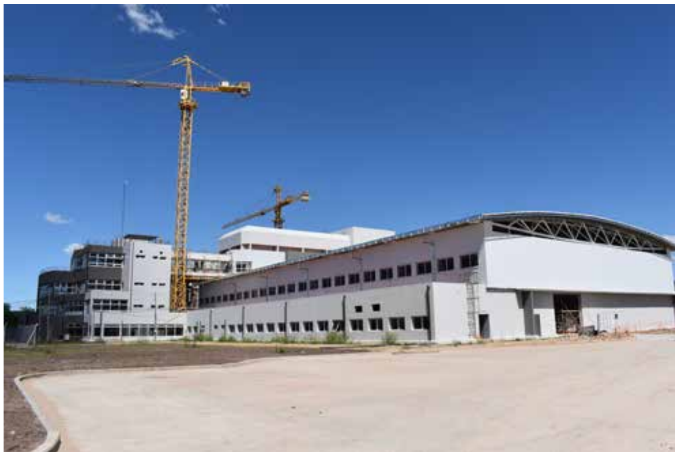
El reactor RA-10 en construcción, 2022. Foto CNEA
