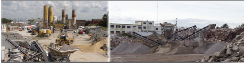
Figura 3. Trituración de la pista de aterrizaje del aeropuerto Jorge Newbery (Gerber 2019)
