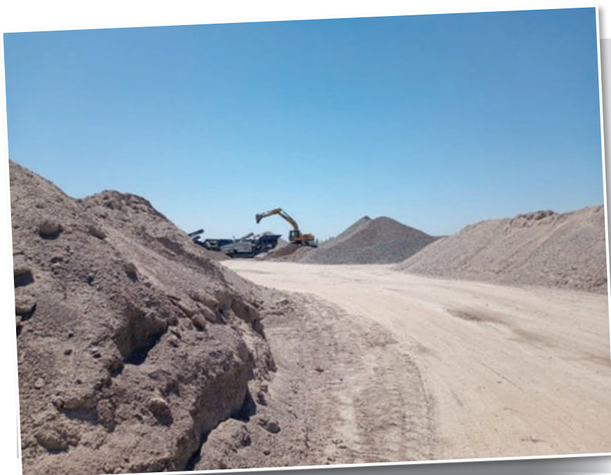
Figura 2. Trituración de residuos de hormigón.
