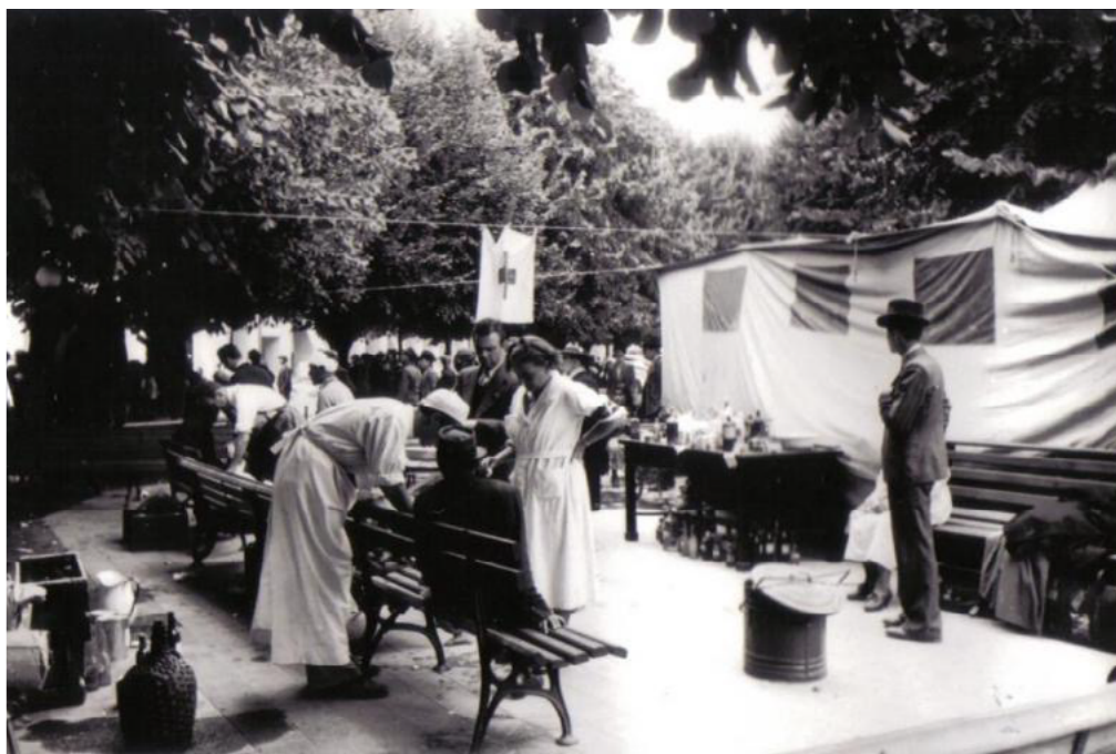
FIGURA 4 Plaza de la Independencia de Concepción posterior al terremoto de 1939. Fuente: Benöhr, Harry. Facilitadas por la familia Benöhr.
