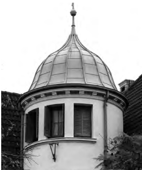
Figura 13: Cúpula de la casa Schenström. Fuente: fotografía del autor.
